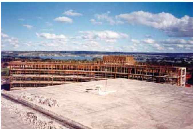
Figura 18 – Detalhe da cobertura de uma construção
