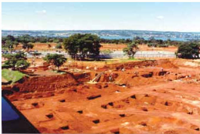
Figura 7 – Vista da locação de uma obra pública
