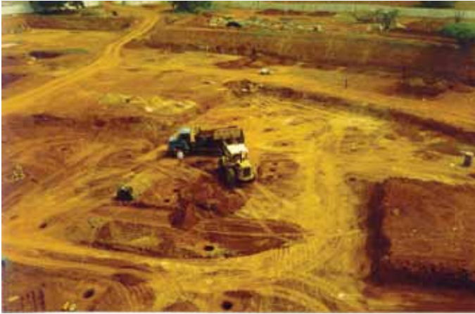
Figura 8 – Vista da execução da terraplenagem de uma futura instituição pública
