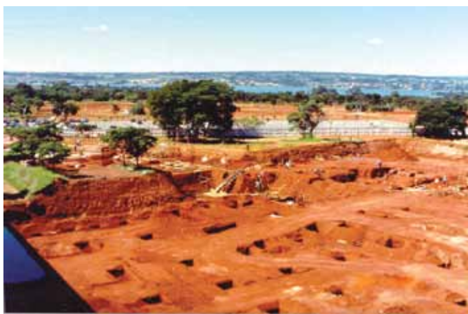
Figura 7 – Vista da locação de uma obra pública
